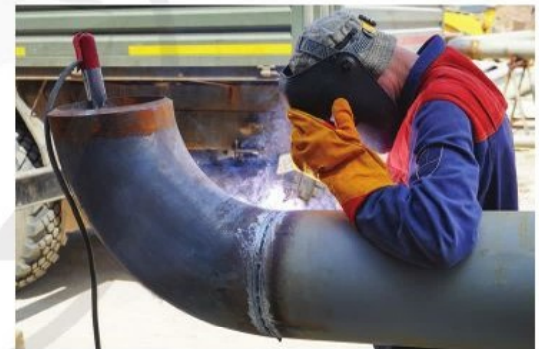
Hình 3.9. Hàn đường ống
