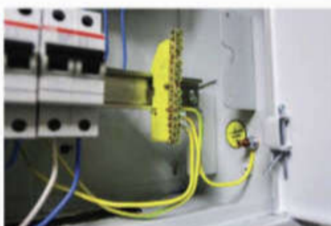
a) Nối đất hệ thống điện
