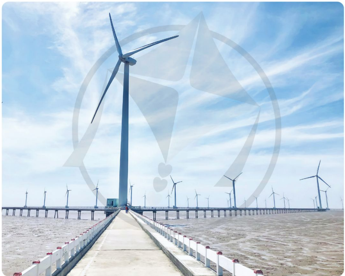
Nhà máy điện gió Bạc Liêu
