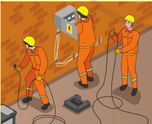
c) Lắp đặt
