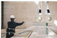
b) Xử lý bề mặt cột điện
