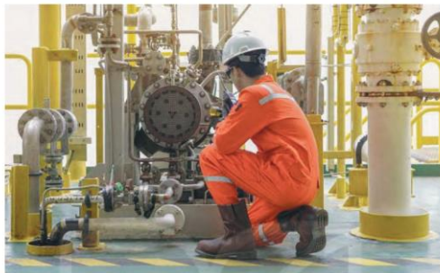
Hình 2.6. Hoạt động bảo dưỡng, sửa chữa thiết bị cơ khí
