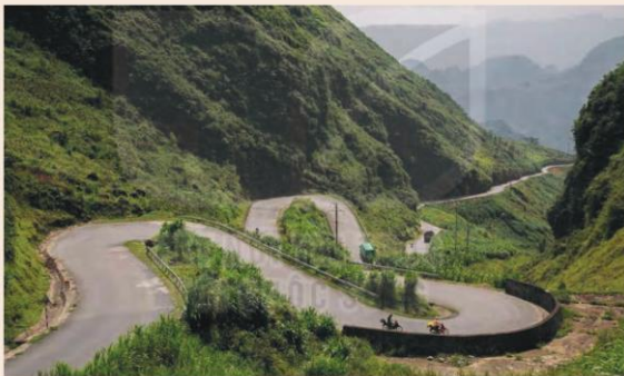
Hình 25.7. Đường đèo dốc dài, quanh co
