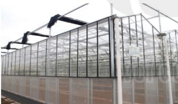
Hình 24.4. Nhà kính hiện đại
