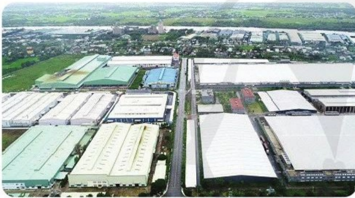
Hình 25.2. Khu công nghiệp – khu chế xuất Tân Thuận ở Thành phố Hồ Chí Minh, Việt Nam
