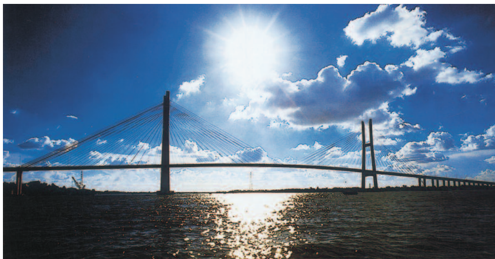
Hình 14.2. Cầu Mỹ Thuận bắc qua sông Tiền
