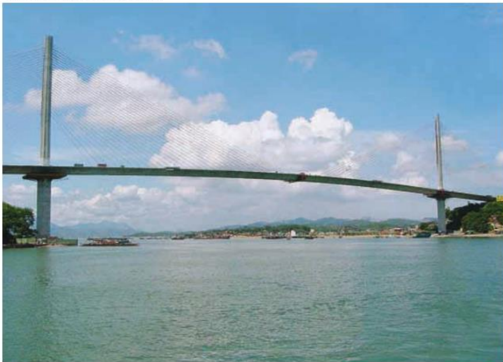
Cầu Bãi Cháy (Quảng Ninh)
