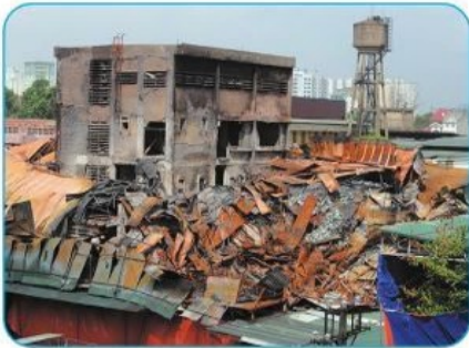
a) Công ty Rạng Đông (Việt Nam) sau vụ cháy (2019)
