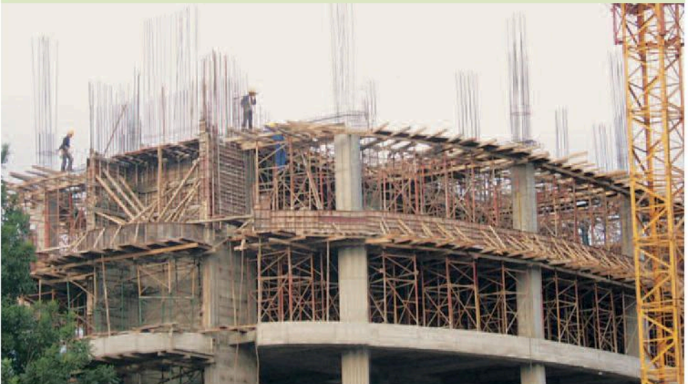
③ Đổ bê tông cốt thép
