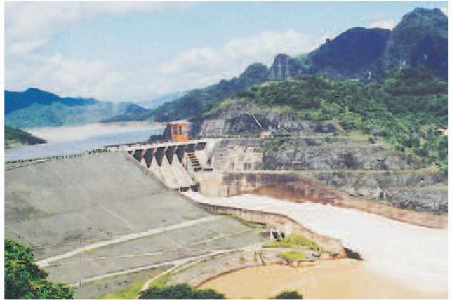
④ Nhà máy thủy điện
