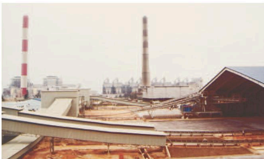
⑤ Nhà máy nhiệt điện
