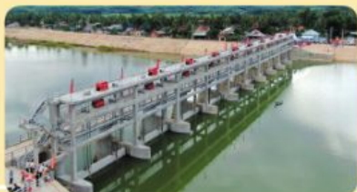
a) Làm đập ngăn nước mặn
