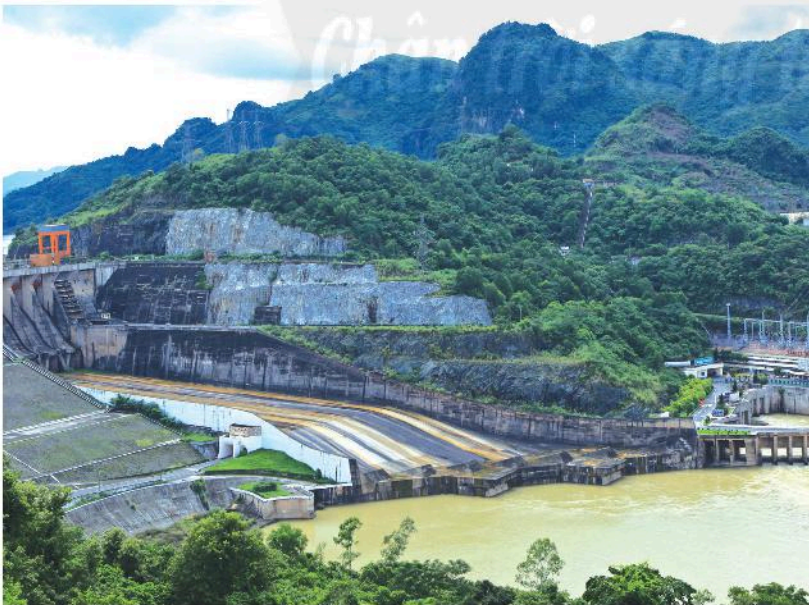
c) Nhà máy thủy điện (Hoà Bình)
