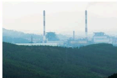
▲ Hình 10.8. Nhà máy nhiệt điện
