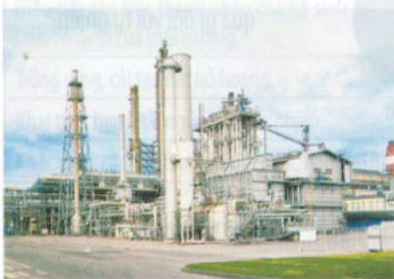
a) Xây dựng các nhà máy
