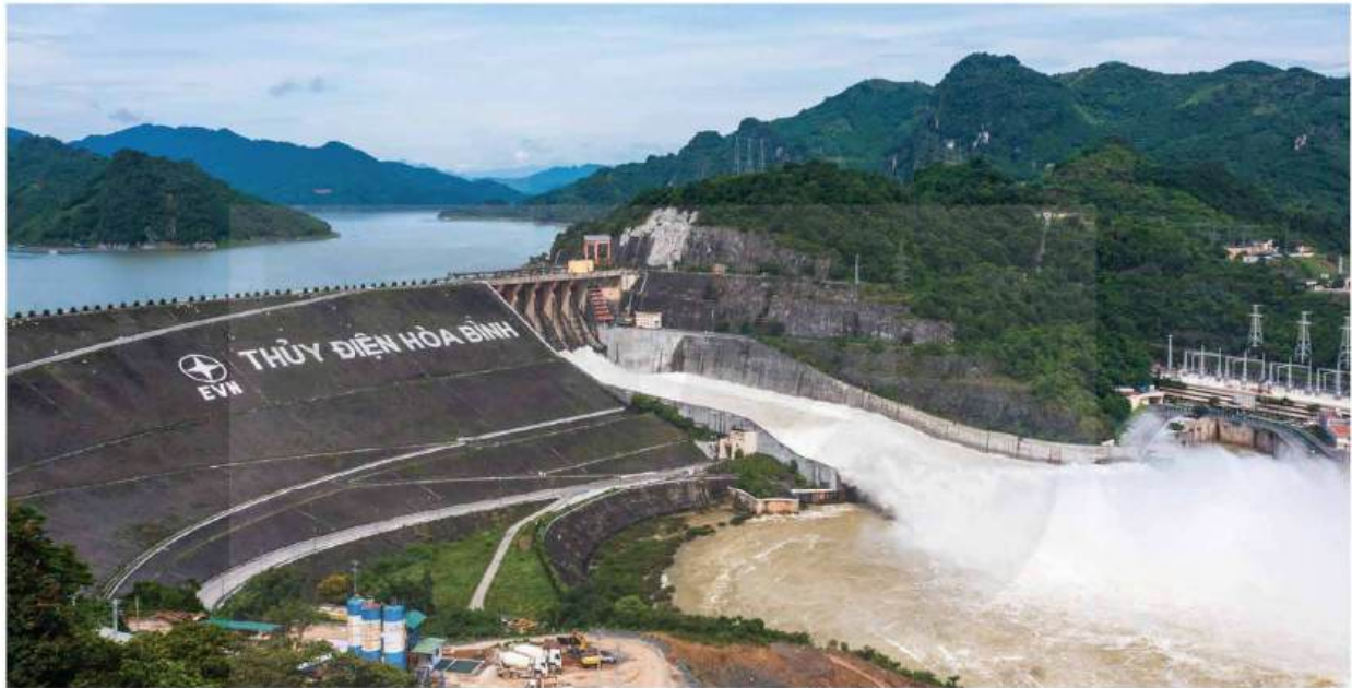
Hình 17.5 Nhà máy thủy điện Hoà Bình
