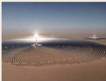
b) Nhà máy nhiệt điện mặt trời trên sa mạc
