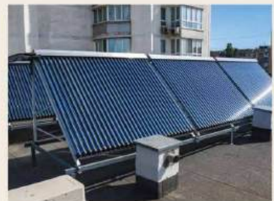
c) Hệ thống thu nhiệt mặt trời lắp đặt trên mái nhà
