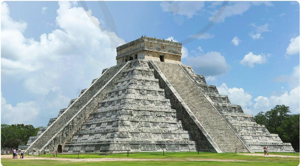
Hình 3.1. Kim tự tháp Chi-chen Ít-da (Mê-hi-cô)
