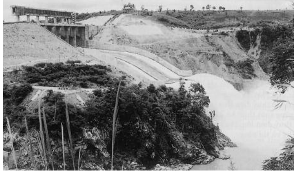
Hình 90. Nhà máy thủy điện Yaly (Gia Lai – Kon Tum)
