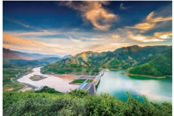
▲ Hình 10. Đập thủy điện Sơn La trên sông Đà (tỉnh Sơn La)
