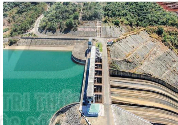
▲ Hình 2. Nhà máy thủy điện Ialy (tỉnh Gia Lai)
