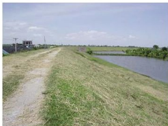
Hình 3. Một đoạn đê sông Hồng
