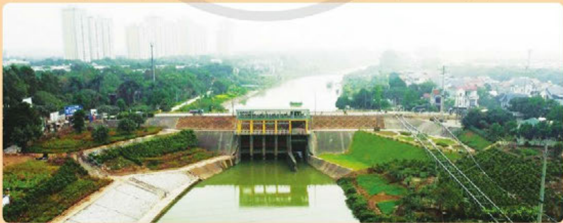
Hình 5. Công Xuân Quan (tỉnh Hưng Yên) – một phần của hệ thống thủy lợi Bắc Hưng Hải
