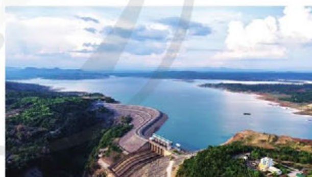
Hình 3. Nhà máy Thủy điện I-a-ly (tỉnh Gia Lai)
