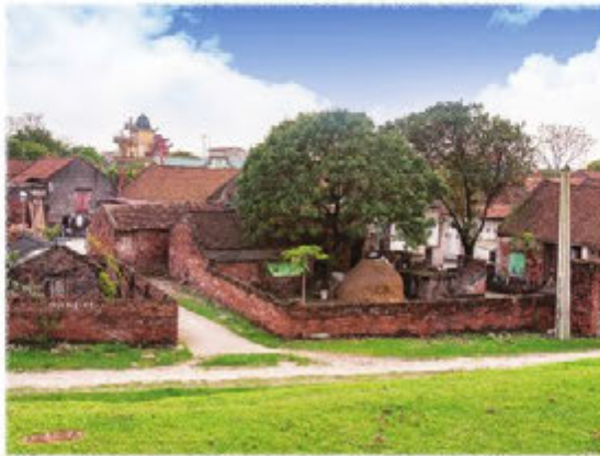
A. Một góc làng cổ Đường Lâm (thị xã Sơn Tây, thành phố Hà Nội)
