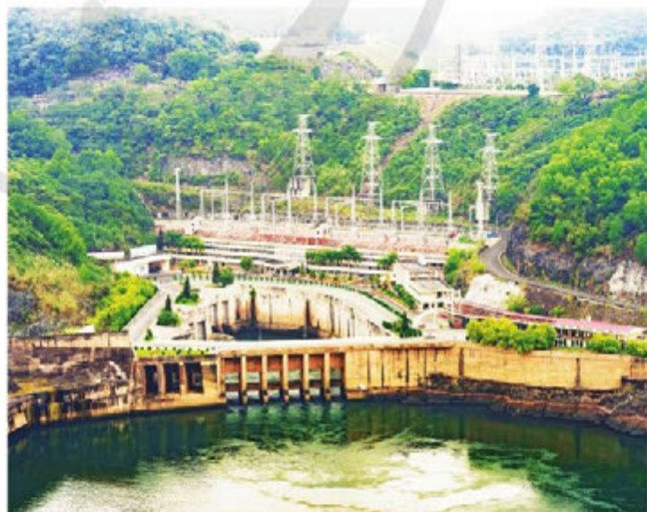
Hình 3. Một góc Nhà máy Thủy điện Hoà Bình (tỉnh Hoà Bình)
