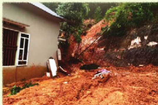
Hình 7. Sạt lở đất
