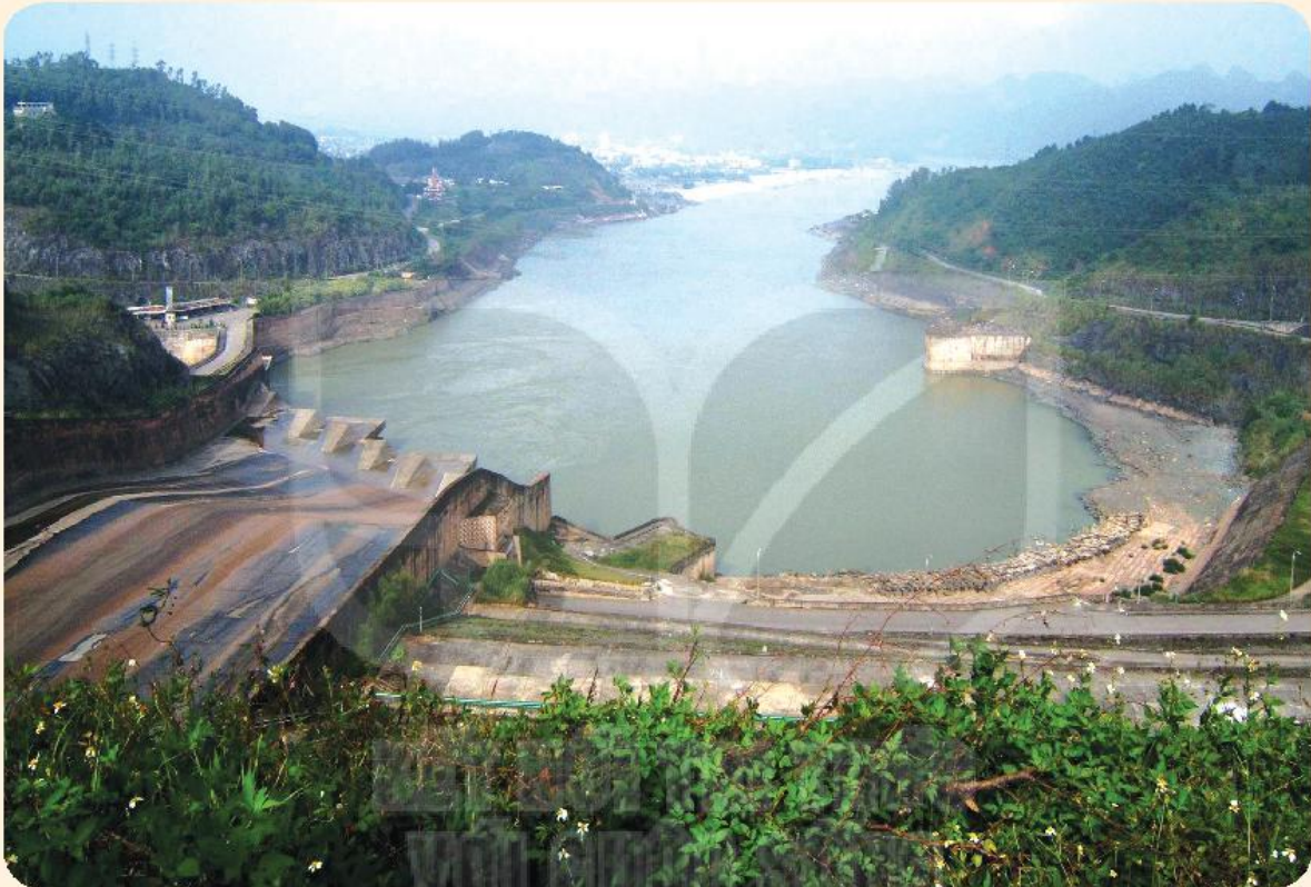
a) Đập thủy điện
