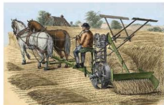
2.3 Máy gặt cơ khí – phát minh của C. M. Cồ-míc (Cyrus McCormick) năm 1831
