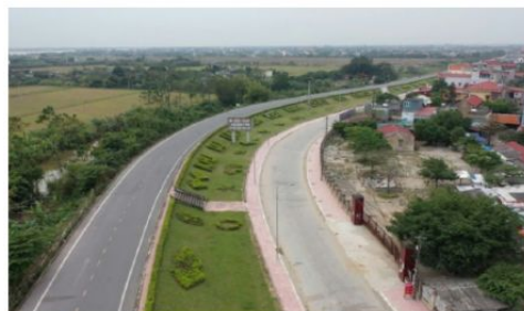
Hình 2.1. Một đoạn đê sông Hồng tại huyện Vũ Thư (Thái Bình)
