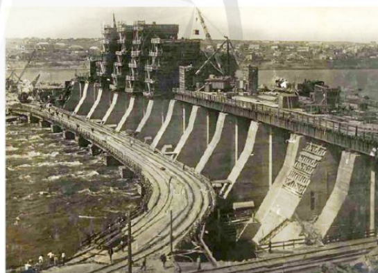
Hình 1.4. Nhà máy thủy điện Đơ-nhép khởi công xây dựng năm 1927
