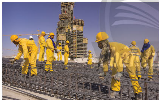
Xây dựng công trình
