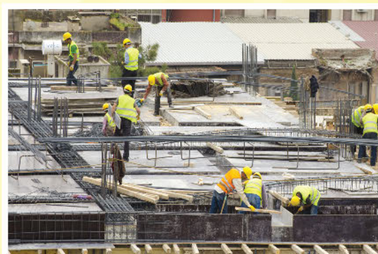
Những người công nhân trên công trường
