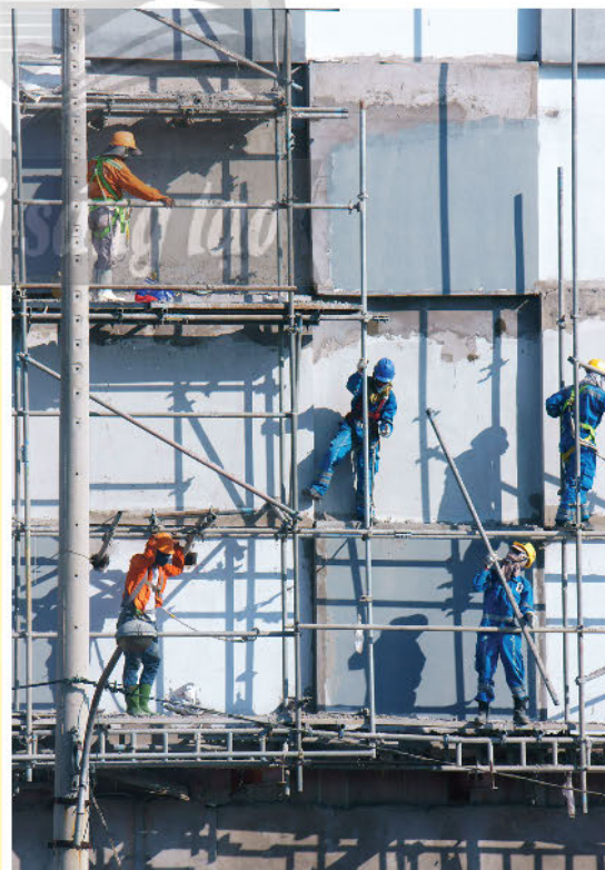
Công trường xây dựng
