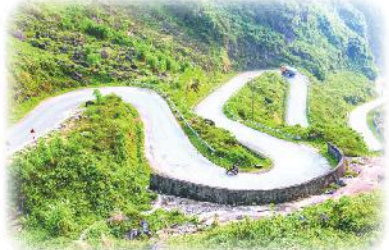
con đường kh★ khu ỷ u
