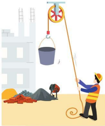
a) Đưa vật liệu lên cao bằng sức người
