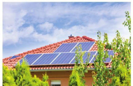
Hình 5. Nhà có sử dụng pin mặt trời
