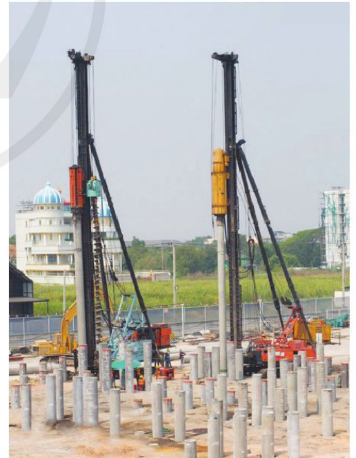
Hình 2.1. Sử dụng búa máy để đóng cọc bê tông
