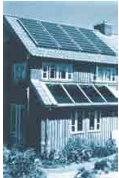
Hình 46.3 Ảnh một ngôi nhà được cấp điện bằng những tấm pin Mặt Trời chế tạo từ bán dẫn silic, đặt trên mái nhà.
